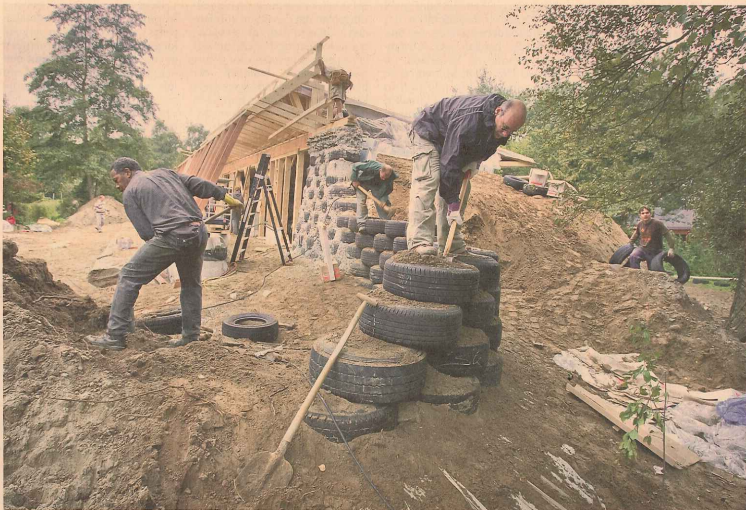
Bij klimaatneutrale bouw volgens het 'earthship'-principe, zoals hier in Zwolle, wordt gebruikgemaakt van afval.
